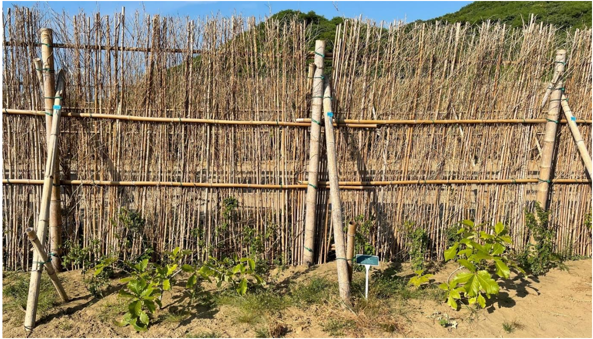
圖 4.16、竹斜撐間距約 2 公尺，區內種植新竹處提供之原生植物，並進行生長監測。
