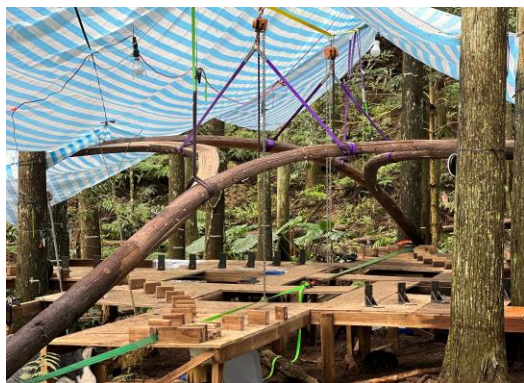
▲主結構懸吊作業
