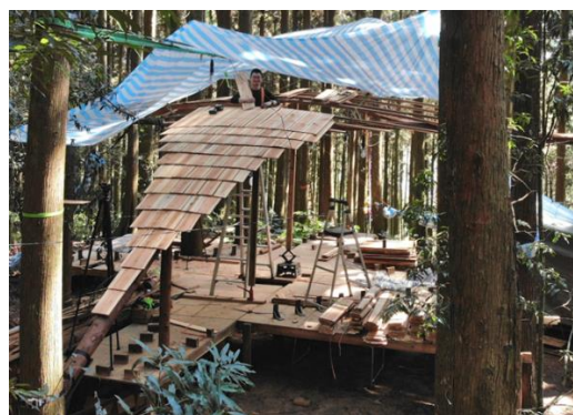
▲木瓦安置作業
