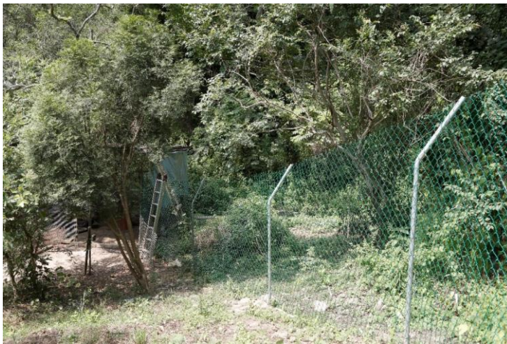
圖 1、PVC 鍍鋅菱形網以及向外彎工的圍網方式
